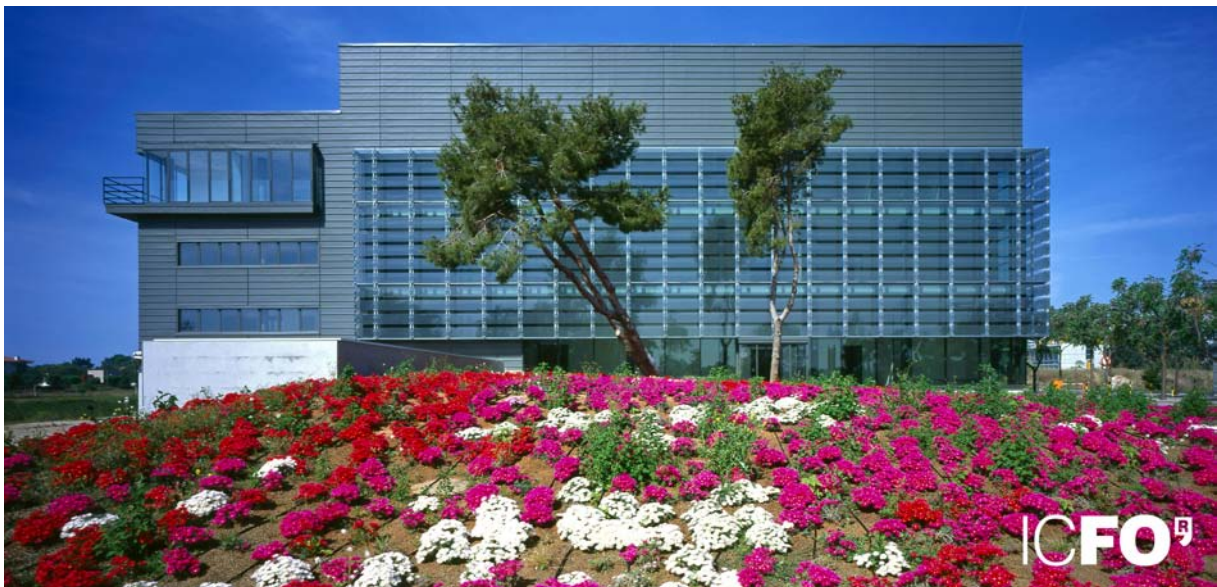
Fig. 1: Edificio que aloja al ICFO, en el Parque Mediterráneo de la Tecnología, de la Universidad Politècnica de Catalunya.
